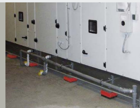
Виброизоляция блочных ТЭЦ с помощью упругих опор
