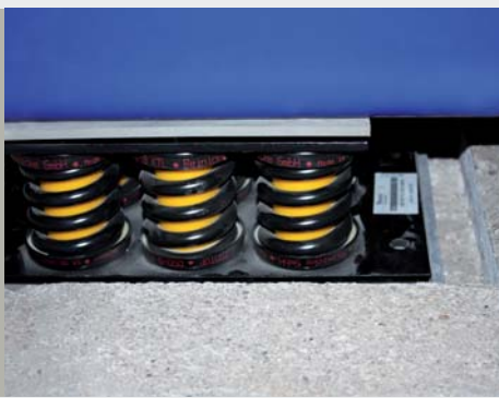
Пружинная виброизоляция блочных ТЭЦ
