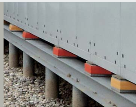
Градирня на эластичных опорах
