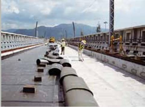
Изоляция системы масса – пружина напротив канализационного трубопровода
